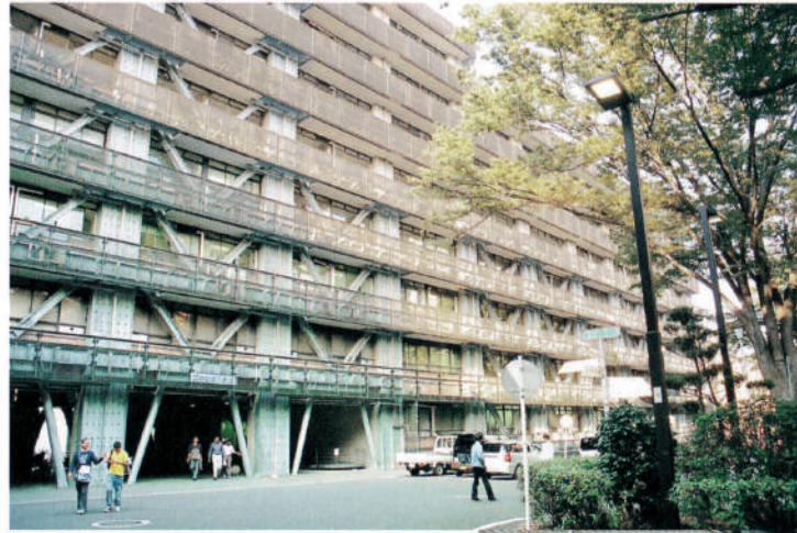
東京大学工学部5号館 設計：東京大学施設部
